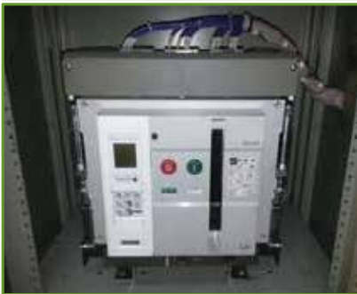
⑧ ACB Retrofit 완료
