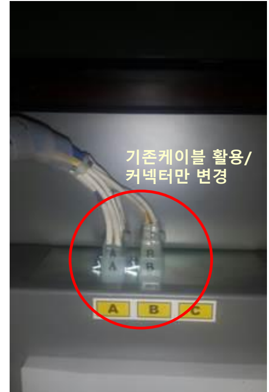
③ 제어커넥터 배선수정작업 및 TEST
