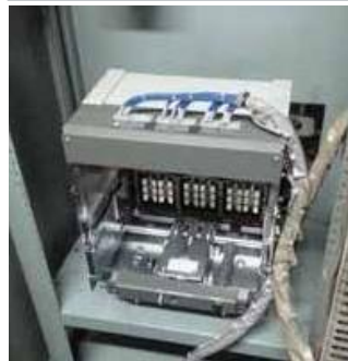
⑥ 크레들 설치
