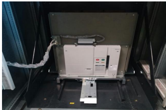
③ Retrofit VCB 인입 및 TEST
