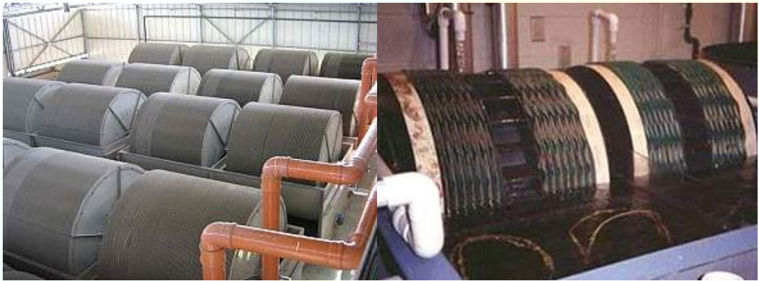
<Fig.> 회전원판여과시스템
