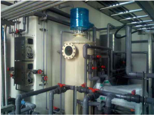
Fig&gt; 단백질스키머 설치 및 작동모습
